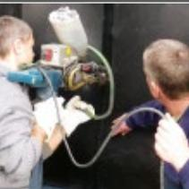
Perfektes „Finish“ für den Bau unterschiedlich dimensionierter, bedarfsindividueller Behälter. Das Bauwerk wird in Spezialtechnik mit der Kunststoffdichtungsbahn ummantelt. Dadurch entsteht ein absolut dichtes, unterirdisches Bauwerk für die Regenwasserrückhaltung. Weitere Informationen siehe Seite 138.
