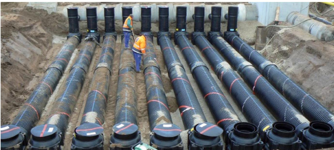
SediPipe (hier 10 x SediPipe 600/12) ersetzt ein Regenklärbecken in Betonbauweise
