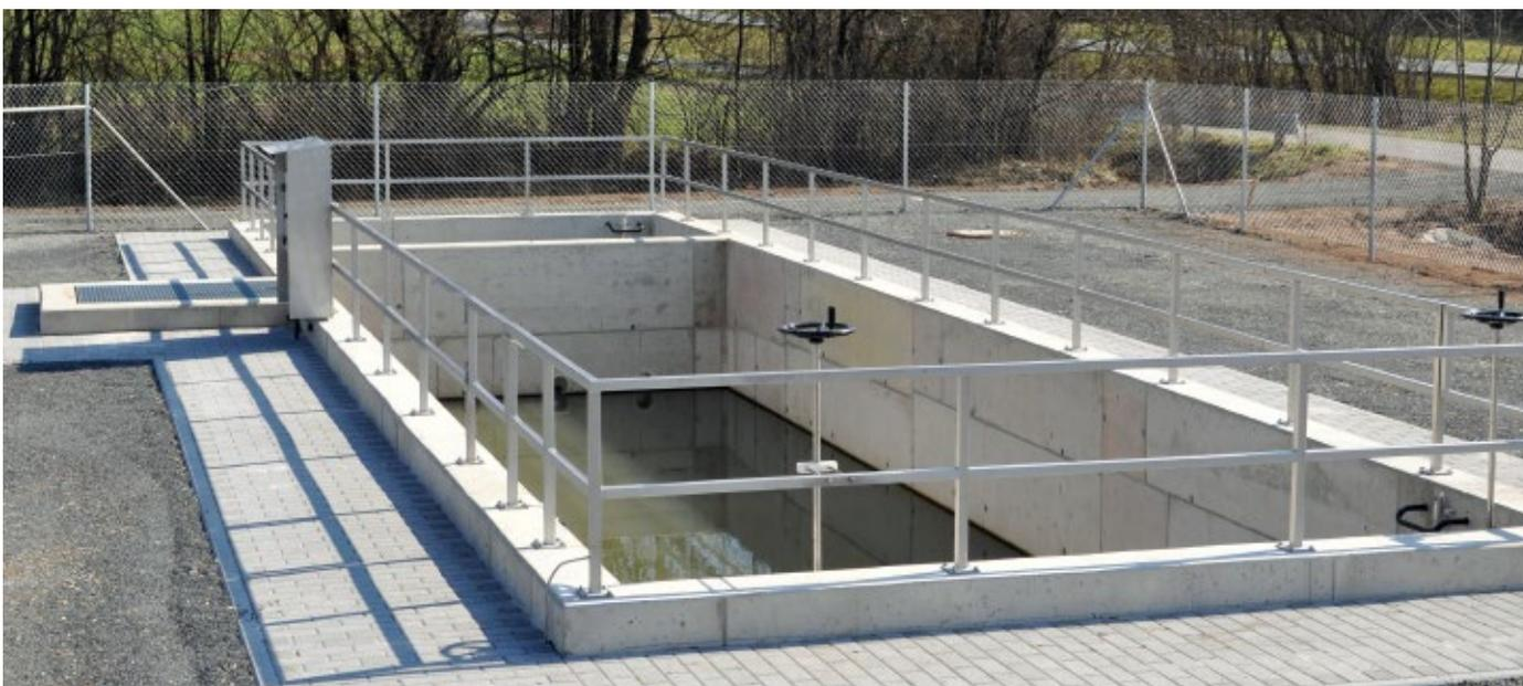
Regenklärbecken in Betonbauweise
