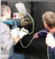
Perfektes „Finish“ für den Bau unterschiedlich dimensionierter, bedarfsindividueller Behälter. Das Bauwerk wird in Spezialtechnik mit der Kunststoffdichtungsbahn ummantelt. Dadurch entsteht ein absolut dichtes, unterirdisches Bauwerk für die Löschwasserbevorratung. Weitere Informationen siehe Seite 138.
