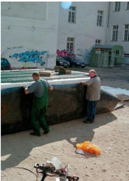
Um Regenwasser als Nutzwasser im Haushalt einsetzen zu können, wird ein RigoCollect-Regenwasserspeicher gebaut. Einer der ersten Schritte ist die Befestigung der Dichtung.
