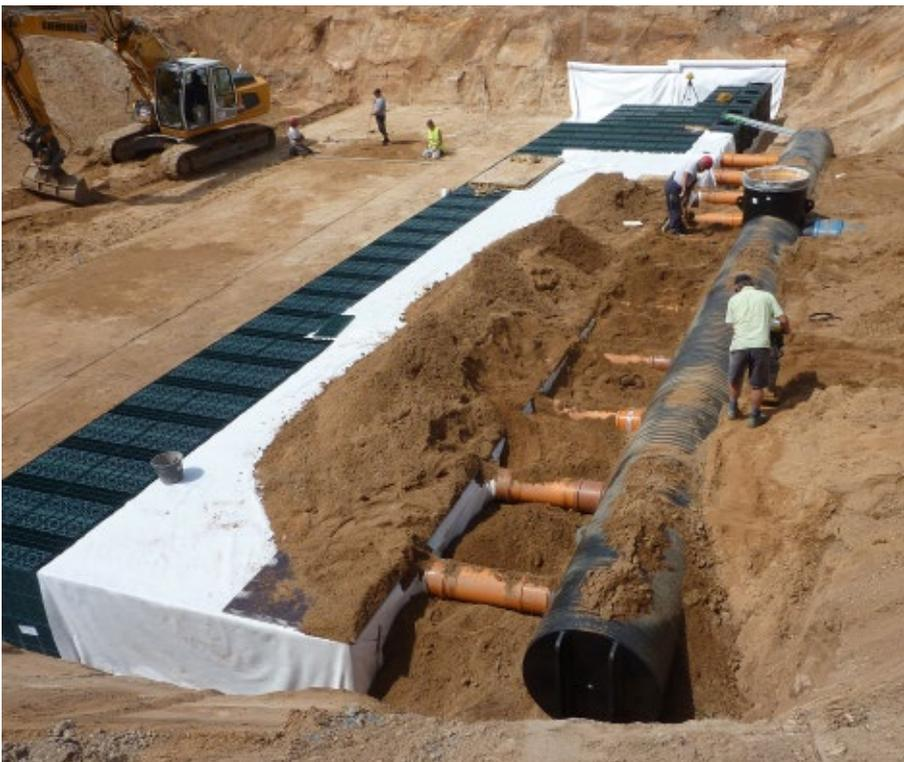
Zweilagige Rigofill-Füllkörperrigole mit Zulaufverteilung
