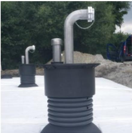
Zur Entnahme von Löschwasser durch die Feuerwehr schreibt die DIN 14230 den Einbau von Saugstellen vor. Diese sind nach DIN 14244 zu gestalten. Es sind Über- und Unterflurvarianten zugelassen. Beide Varianten werden werks-
