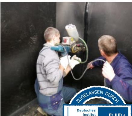
Die Kunststoff-Dichtungsbahn (KDB) aus Polyethylen hoher Dichte (PE-HD) hat sich seit vielen Jahren als optimal für den Grundwasserschutz erwiesen. Die Verfahren für Verarbeitung, Prüfung, Dokumentation und Zertifizierung wurden aus dem Deponiebau übernommen, wo sie sich seit nahezu 40 Jahren hervorragend bewährt haben.
