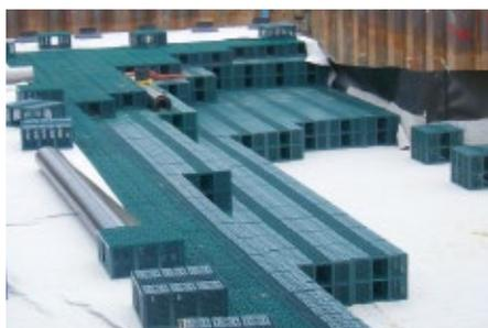
Rigofill-Füllkörperrigolen können in Länge und Breite nahezu beliebig geplant werden. Das quadratische Rastermaß von 80 cm ermöglicht eine gute Anpassung an nahezu jeden Grundriss. Mit dem Höhenraster 66 cm (Vollblock) bzw. 35 cm (Halbblock) können Anlagen in beliebiger Kombination ein- und mehrlagig gebaut werden. Damit kann die Rigole sehr variabel an die örtlichen
