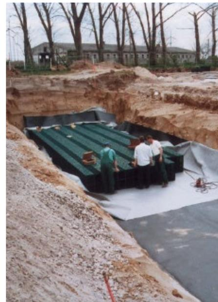
Die RigoCollect-Regenwasserspeicher können aufgrund des Blockrasters in nahezu beliebigen Größen und Geometrien gebaut werden.
