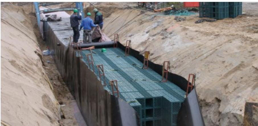
Die geometrische Flexibilität ermöglicht die Einpassung der benötigten Volumina auch bei beengten und schwierigen Bauverhältnissen. Beim Bauen im Bestand kann durch ein „Wanderndes Baufeld“, bei dem nur ein kleiner Teil der Baugrube jeweils offen ist, die Nutzungsunterbrechung von Verkehrsflächen minimiert werden.
