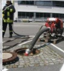
Erfüllt die DIN 14230-Vorschrift zur Entnahme von Löschwasser durch die Feuerwehr. Einsatz von Über- und Unterflurvarianten nach DIN 14244. Auch die Ausstattung mit z. B. handbetätigten oder automatisierten Absperrschiebern ist jederzeit nach Bedarf möglich. Weitere Informationen siehe Seite 140.
