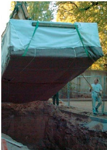
Der Speicher kann im Werk bis zu einer bestimmten Größe vorgefertigt werden. Der Einbau ist deshalb für Fachleute nur noch eine Routinearbeit.
