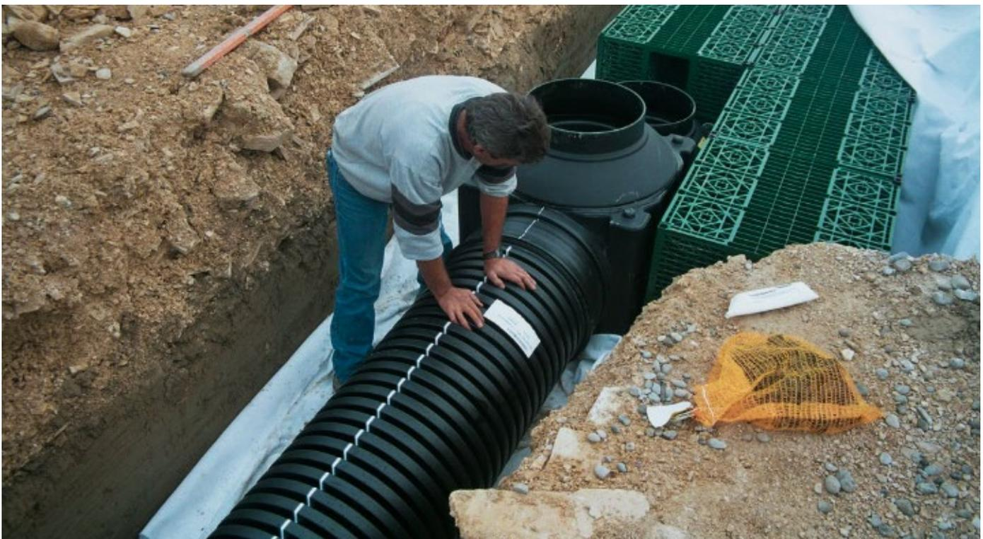
Sedimentationsrohr und Zielschacht mit Anschluss an Füllkörperrigole
