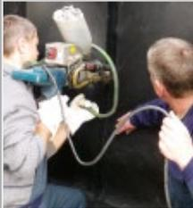
Perfektes „Finish“ für den Bau unterschiedlich dimensionierter, bedarfsindividueller Behälter. Das Bauwerk wird in Spezialtechnik mit der Kunststoffdichtungsbahn ummantelt. Dadurch entsteht ein absolut dichtes, unterirdisches Bauwerk für die Regenwassernutzung. Weitere Informationen siehe Seite 138.
